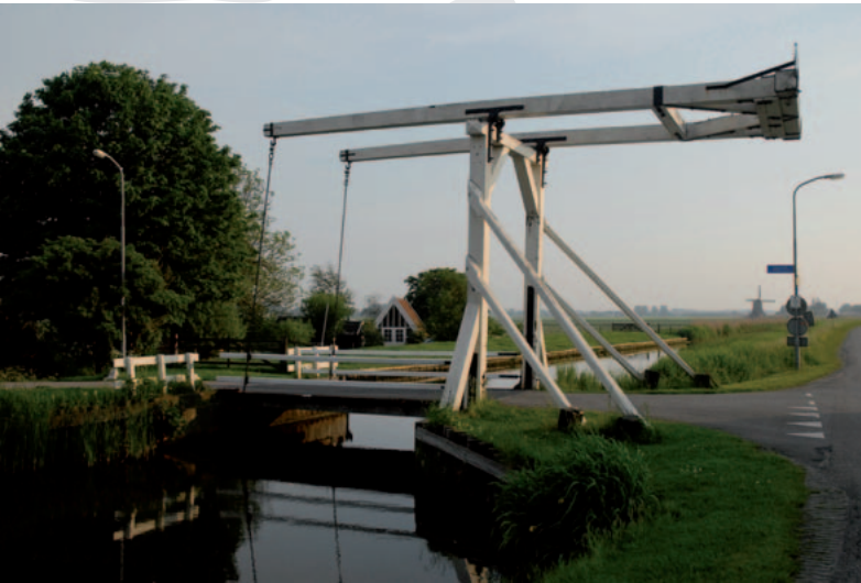
> Wipbrug in Spanbroek
